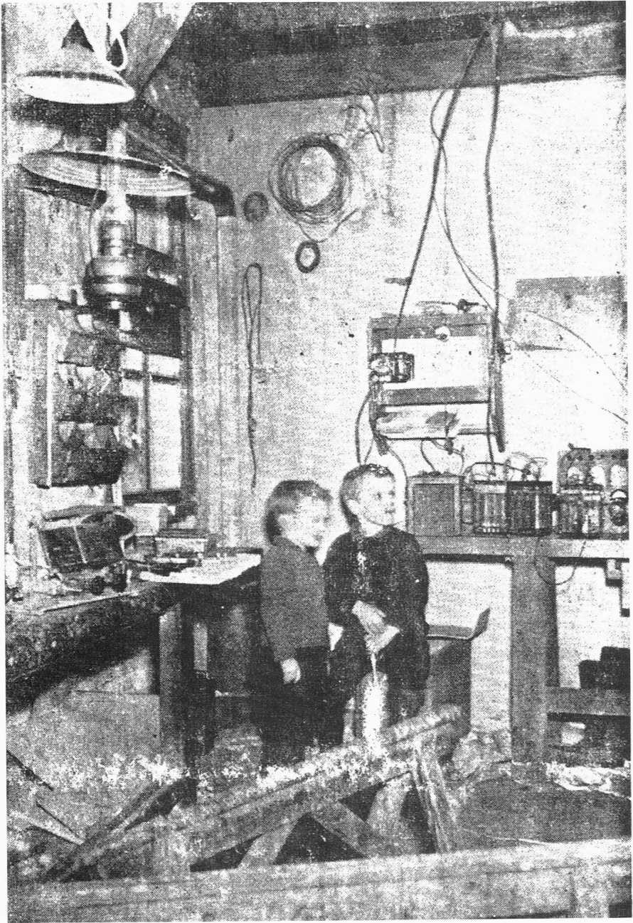
In den werkplaats van den jongen Renskers. Tegen de achterwand het schakelbord en de ampèremeter. Op den voorgrond ziet men nog juist de electr. lamp, die op de installatie werkt.
