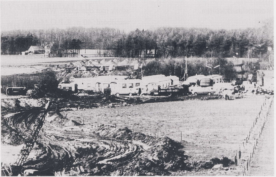
Het oude woonwagenkamp nabij het Hilgelo waar de graafwerkzaamheden reeds zijn begonnen. (foto mrt. 1969).
