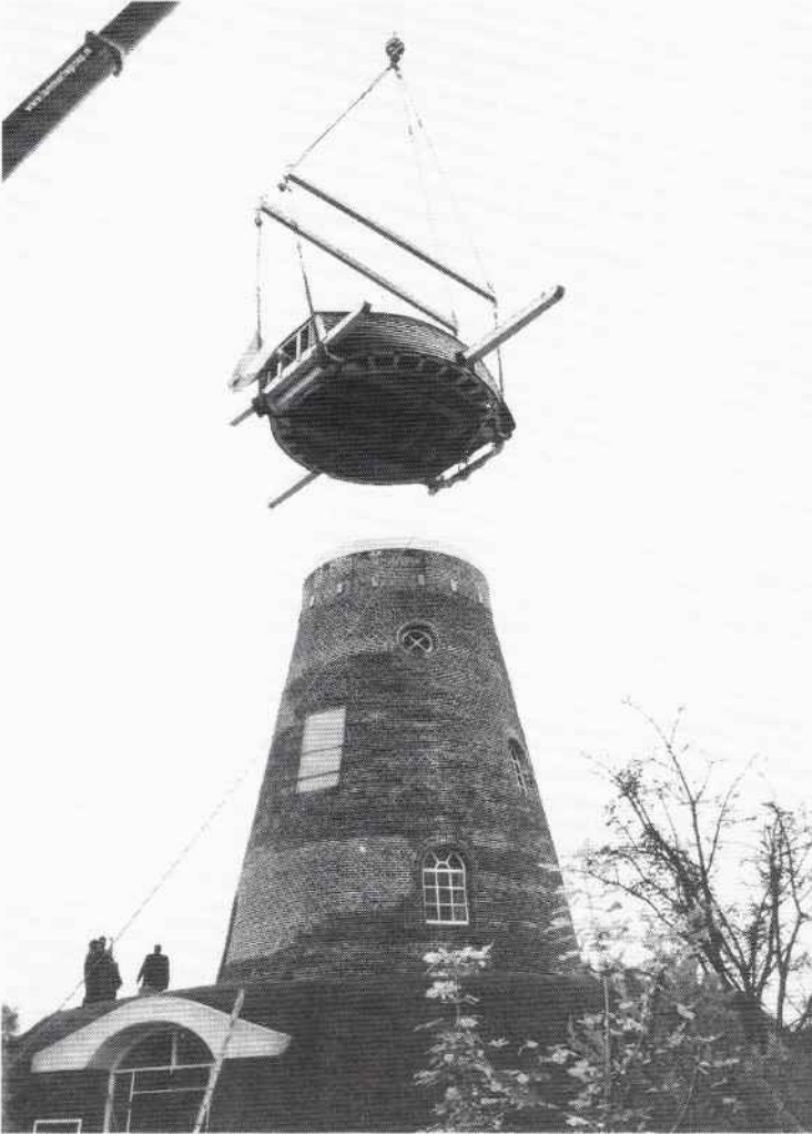
Plaatsing van de molenkap op de molenromp op 30 09 2000
